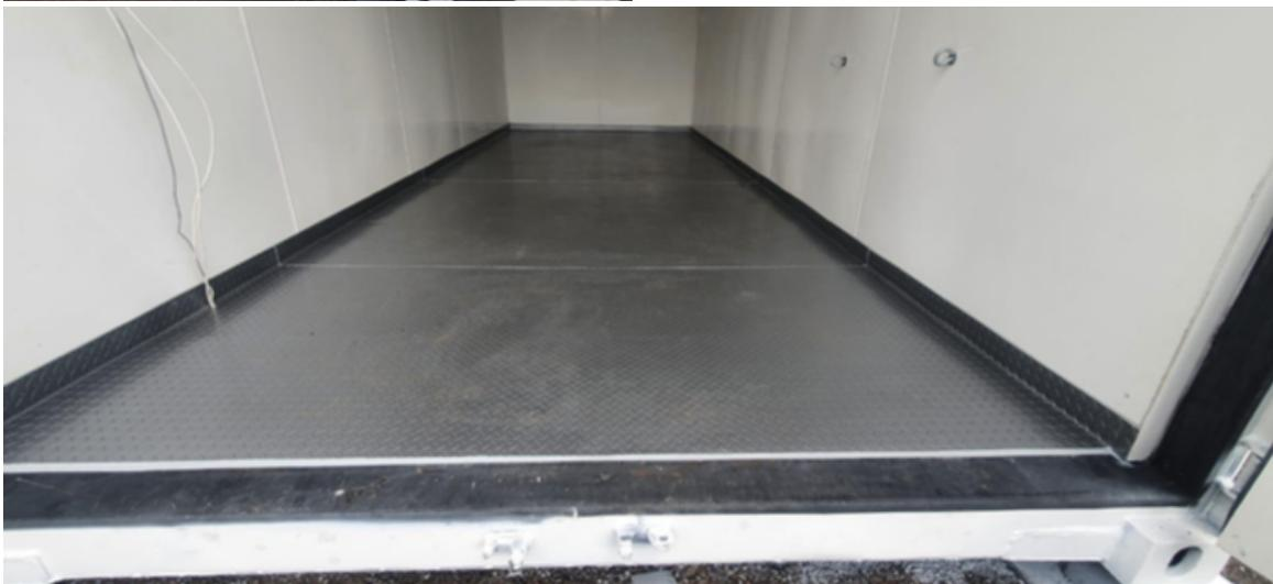
Figura 3. Fotos de los acabados del contenedor al día de hoy, en donde se muestra la aplicación del aislamiento, paredes, pisos y pintura exterior (cuatro manos de *primer* y cuatro manos de pintura esmalte para evitar corrosión).
