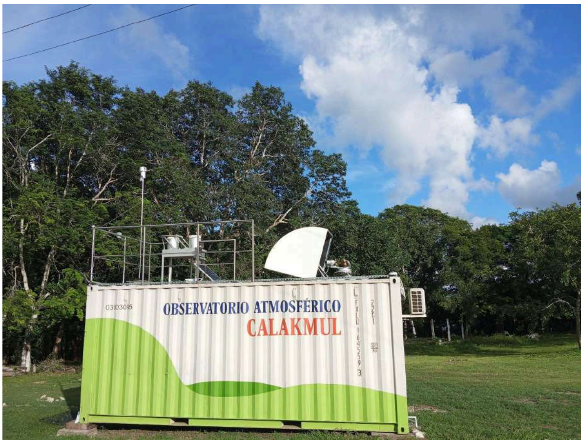
Figura 2.1 Fotografía del Observatorio Atmosférico Calakmul, instalado en la inmediaciones de la Reserva de la Biosfera de Calakmul en Zoh Laguna, Campeche. Consta de un contenedor marítimo adecuado como laboratorio móvil para la medición de contaminantes atmosféricos y gases de efecto invernadero.
